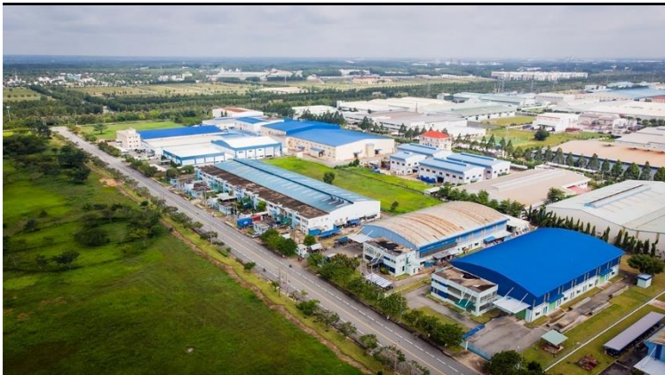
Hình 13: KCN VSIP III
