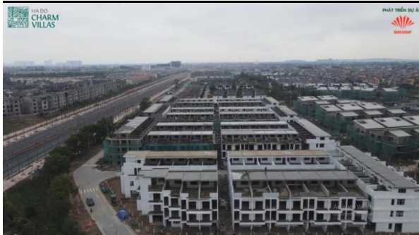
Hình 4: Dự án Charm Villas
