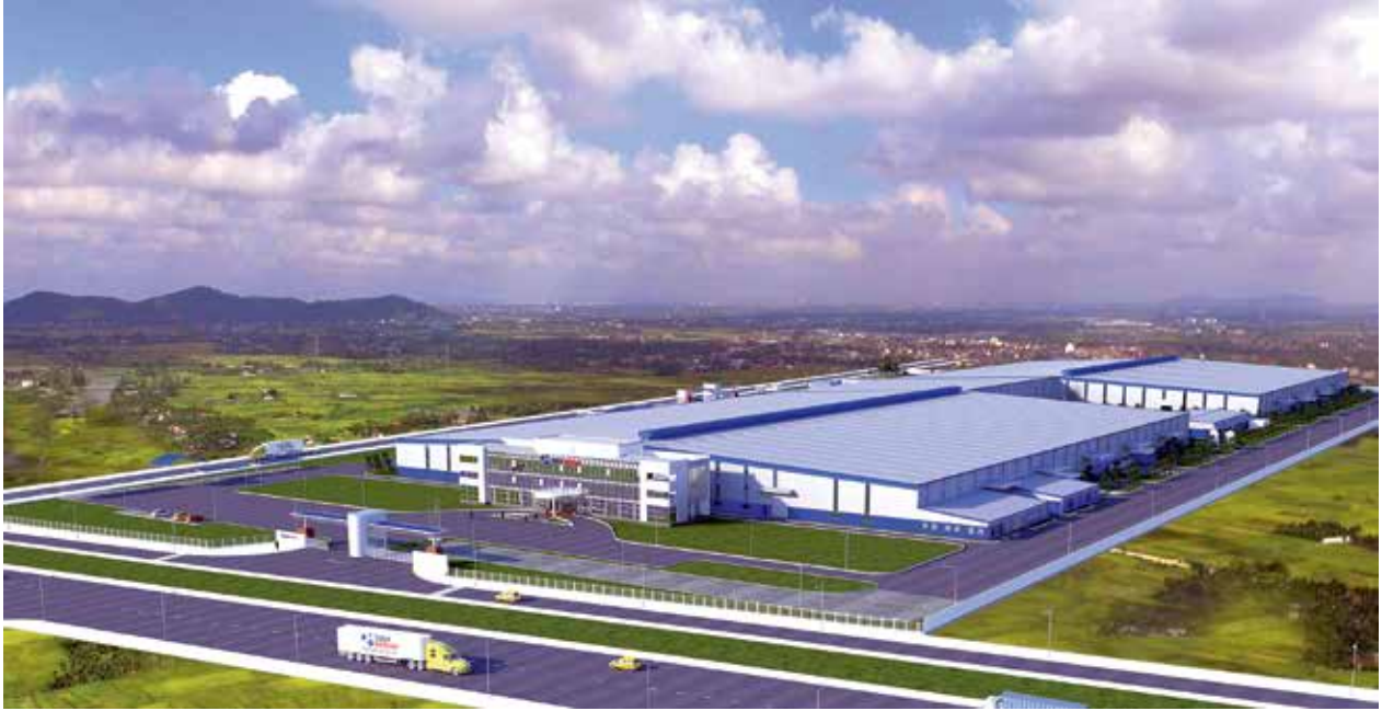
Nhà máy Tân Á Hà Nam với quy mô lớn nhất Việt Nam và khu vực sẽ sớm đi vào hoạt động
