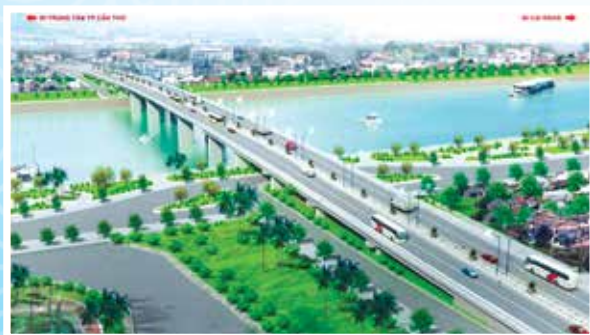
Cầu Quang Trung nhánh 2 chính thức xây dựng vào đầu năm 2017.
