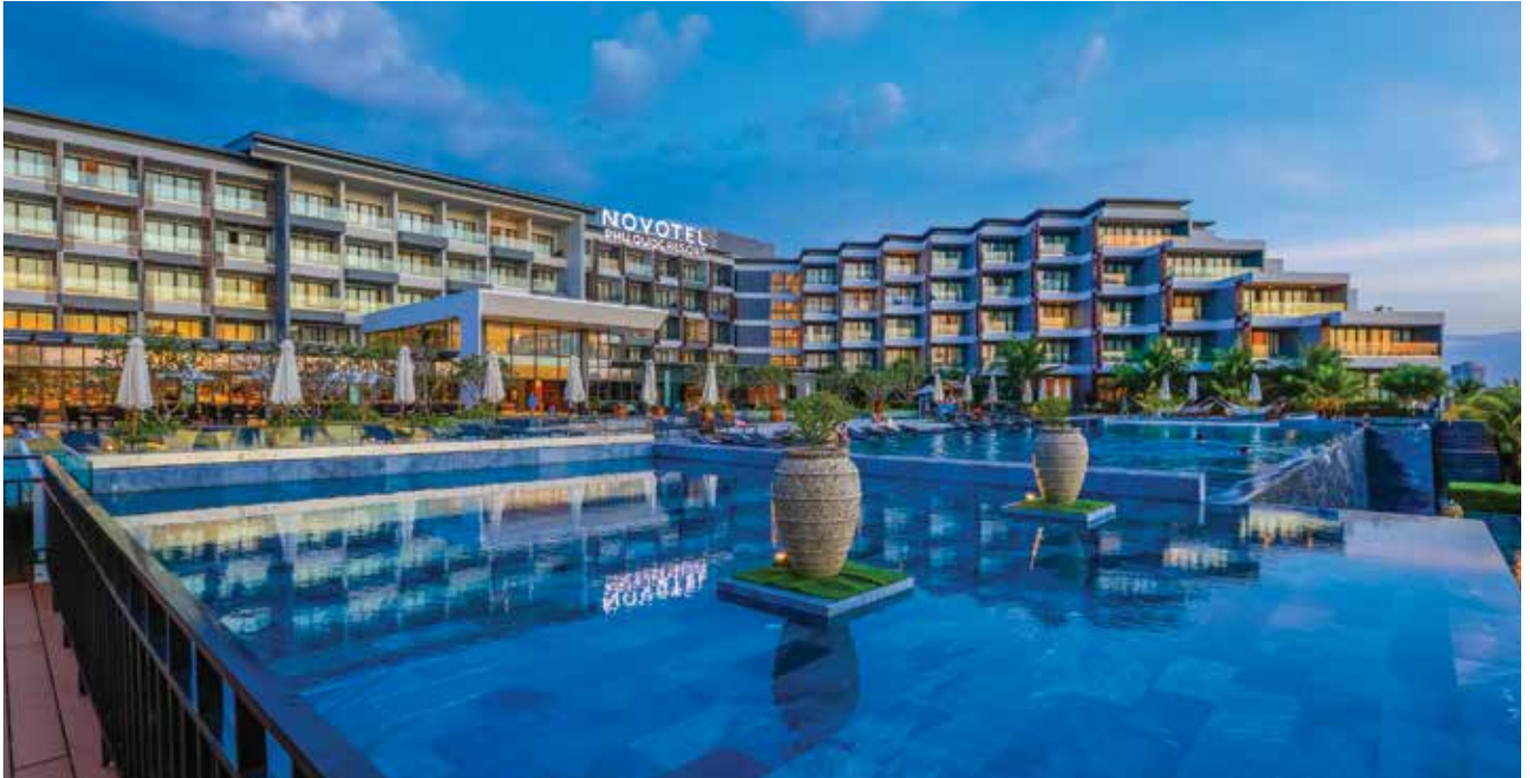
* Dự án bất động sản nghỉ dưỡng tốt nhất - Khu du lịch nghỉ dưỡng đẳng cấp Novotel Phu Quoc Resort
