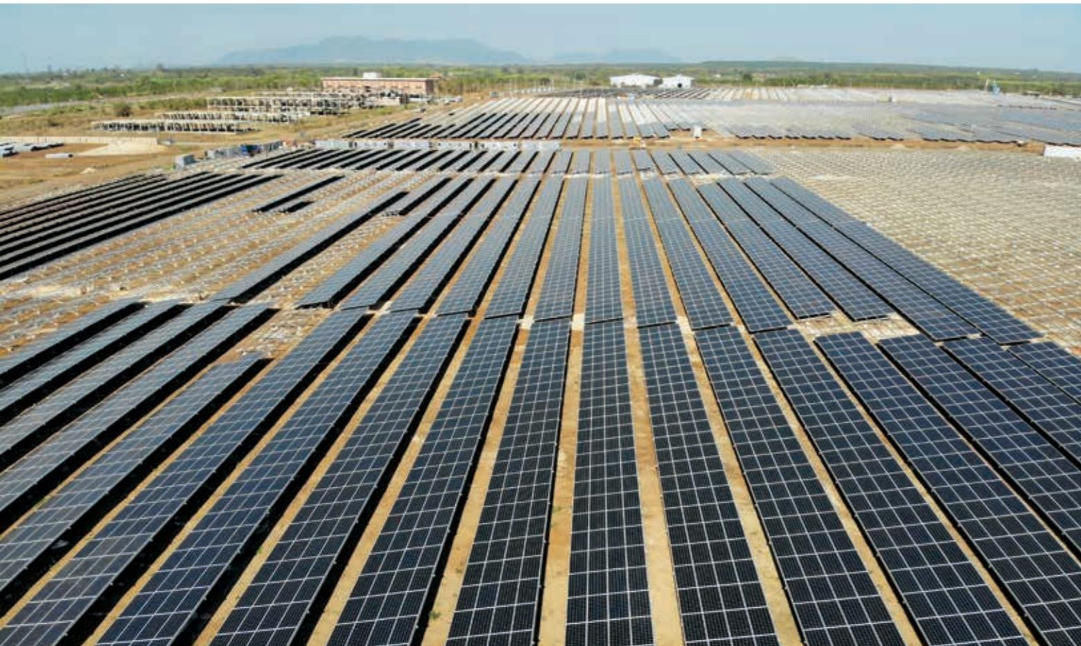
Một nhà máy điện mặt trời đang được triển khai ở Tây Nguyên
