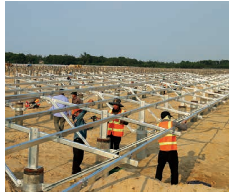
Trên công trường thi công nhà máy điện mặt trời 50 MWp tại xã Cẩm Hòa, huyện Cẩm Xuyên (Hà Tĩnh), do Công ty CP Tập đoàn Hoàn Sơn làm chủ đầu tư
