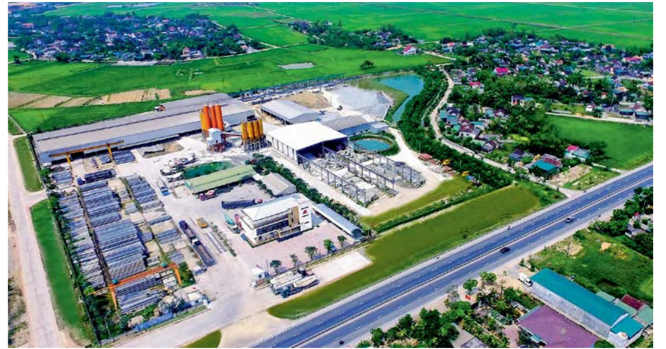
Nhà máy sản xuất vật liệu & cấu kiện bê tông của Công ty Việt Hải tại xã Việt Tiến (Thạch Hà).
